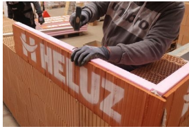
Eckeneinrichtung und Stabilisierung der Ziegelblocks mit Hilfe von Schlagankern.
