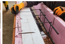
Vor dem Betonieren wird die Oberseite mit Klammern verbunden, die in der Höhe der Rostoberkante eingeschlagen werden.
