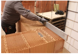
Ebenheit des Mauerwerks überprüfen.
