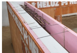
Die Rostbewehrung wird verlegt.
