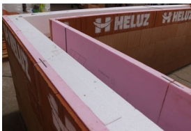
Nach dem Verlegen der Wärmedämmung sind die Fugen auf der Innenseite des Kranzes auf Dichtigkeit zu prüfen.
