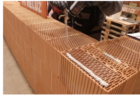
Die Ziegelblöcke werden mit PU-Schaum geklebt.
