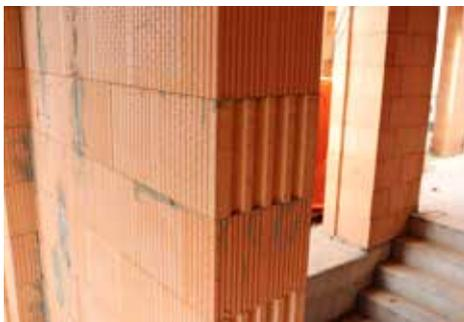
Laibungen von Bauöffnungen werden mit Nuten bzw. mit Federn der Ziegel, nicht mit geschnittenen Ziegelseiten, abgeschlossen.
