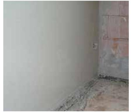
③ Innenputze werden vom Rohbau Fußboden bis zur Decke durchgeführt.
