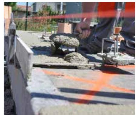
⑥ Wir füllen die Spalten nach dem Anlegesatz mit Mörtel aus. Auf markierte Öffnungen tragen wir keinen Mörtel auf.
