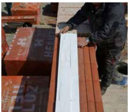
⑤ Zwischen den Stürzen wird eine wärmedämmende Isolierung mit gleicher Höhe eingelegt. Die Anzahl der Stürze wird in Übereinstimmung mit dem Projekt gewählt. Der keramische Formstein bei Randstürzen wird so versetzt dass der keramisch Teil immer in Richtung Mauerwerk Außen- bzw. Innenseite gerichtet ist.
