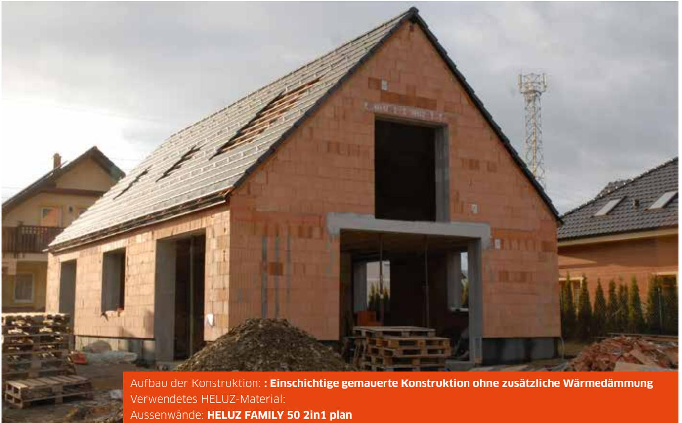
Aufbau der Konstruktion: **: Einschichtige gemauerte Konstruktion ohne zusätzliche Wärmedämmung**
