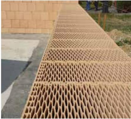
7 Die Ziegel werden, durch Einschieben der Federn in die Nuten, stoßdicht gesetzt.
