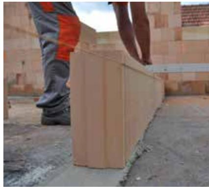
② Die erste Reihe geschliffener Ziegel wird auf ein ausgeglichenes Mörtelbett in der gleichen Höhe wie das Außenmauerwerk und das tragenden Innenmauerwerk angelegt. Alternativ wird die erste Ziegelreihe auf eine kleinere Stärke des ausgeglichenen Mörtelbetts der Stärke mind. 6 mm angelegt. Die Edelstahlanker zum Verbinden der Trennwände werden nachträglich montiert (Vorgehensweise auf Seite 49).
