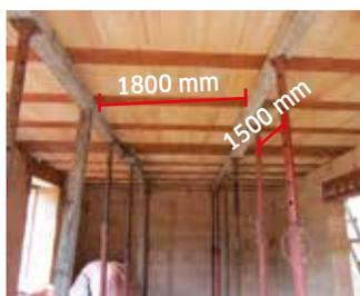
**Der Abstand zwischen den Stützen oder zwischen der Stütze und dem Mauerwerk beträgt max. 1800 mm.**
