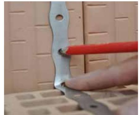
① Der Wandanker wird 100 mm ab dem Ende L-förmig gebogen und mit der kürzeren Seite an die bestehende Wand befestigt
