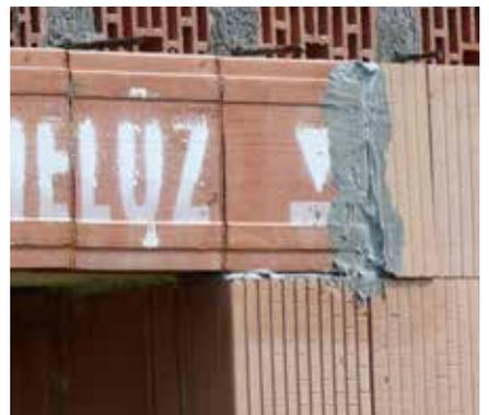
⑦ Die senkrechte Fuge zwischen dem Ende des Sturzes und dem Mauerwerk ist mit wärmedämmenden Mörtel HELUZ TREND zu vermörteln. Spalten von mehr als 15 mm werden mit Ziegelzuschnitt ausgefüllt und vermörtelt.
