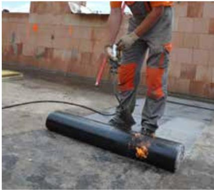
① Das Anlegen der ersten Reihe wird in der Regel auf ein angeflämmtes schweres Bitumenband mit der Mindeststärke 2,5 mm durchgeführt, das mind. 150 mm auf jeder Seite der verputzten Wand herausragt. Es ist erforderlich die gegenseitige Verbindung der Feuchtigkeitsisolierung zu beachten.
