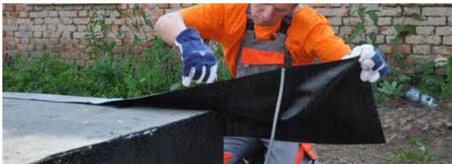
Vorbereitung des Untergrunds zum Auftragen des Mörtels (der Mörtel wird auf eine ebene, zusammenhaltende und abgedichtete Oberfläche - z. B. auf aufgeflämmte Bitumenbänder gelegt).
