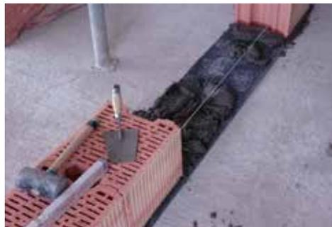
Ziegel werden in ein Mörtelbett auf ein schweres Bitumenband mit einer Mindeststärke von 3 mm verlegt.
