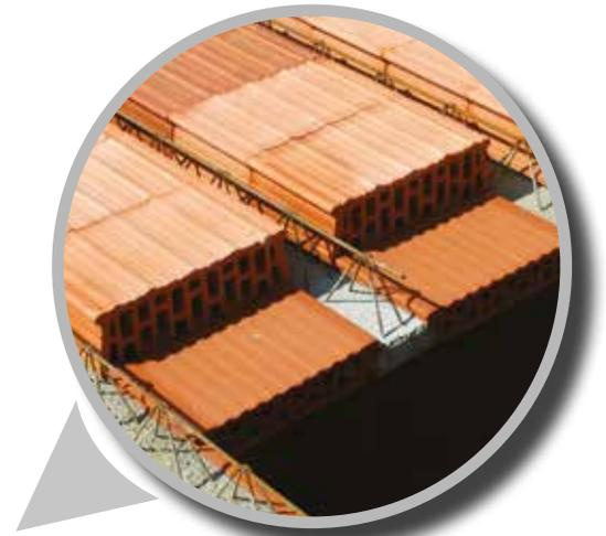
An Stellen mit großen Öffnungen (z. B. Ausstieg auf das Dach, Treppenhaus) werden sog. Wechsel durchgeführt.
