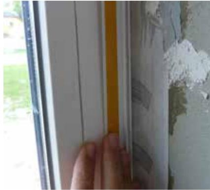
⑩ Vor dem Verputzen werden auf den Fensterrahmen Dicht- und Abschlussleisten geklebt.
