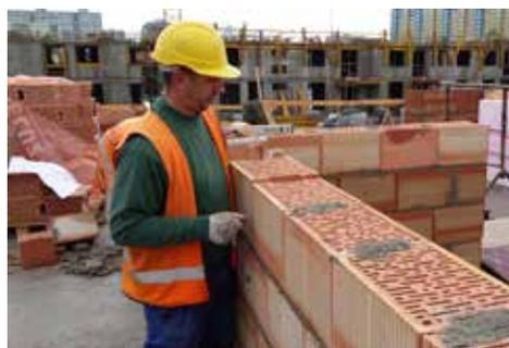
Beim Mauerwerk aus AKU Ziegeln beträgt die Mindeststärke des Mörtelbetts 10 mm. Beim Mauerwerks aus Ziegeln des Typs AKU MK muss man die Mörteltaschen ausfüllen.
