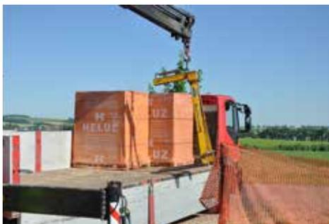
Die Be- und Entladung ist auf die Möglichkeiten des Transportmittels und die Transportbedingungen anzupassen. Bei fachgerechter Manipulation können Beschädigungen der Ware ausgeschlossen werden. Zu ihrer Entladung dienen eine Hubeinrichtung oder ein Hubwagen. Zur Manipulation mit Paletten empfehlen wir die spezielle „C“ Aufhängung. Wir stellen Paletten auf eine, im Vorfeld vorbereitete und ebene, Oberfläche ab.
