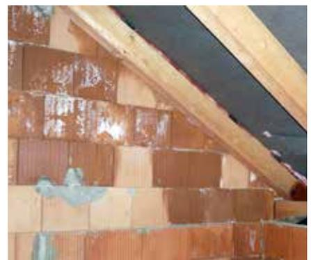
Ausblühungen am feuchten Mauerwerk müssen nach dem Austrocknen mechanisch gereinigt werden.
