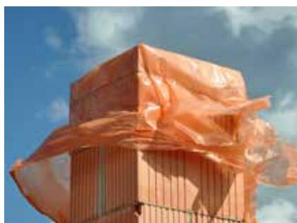
Bei der Unterbrechung des Baus des Kamins muss eine Abdeckung des Kamins durchgeführt werden, damit es zu keiner Beschädigung durch Regen oder Bauschutt kommt.
