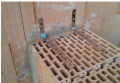
Die Verankerung des Innenmauerwerks, bzw. der Trennwände wird durch Einlegen von flachen Edelstahlankern in die Lagerfugen des Außenmauerwerks hergestellt. Anker werden in der Regel in jeder zweiten Lagerfuge platziert oder alternativ nachträglich eingesetzt (siehe hierzu Seite 49).
