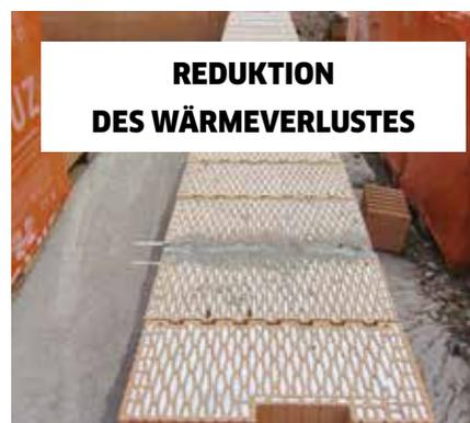
Zur Reduzierung von Wärmeverlusten empfehlen wir in der ersten Reihe die Ziegel HELUZ Family 2in1 zu verwenden.
