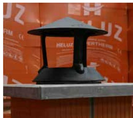
⑨ Auf das angepasste, saubere Kamineinsatzrohr tragen wir Fugenmörtel (HSS) auf und setzen darauf den Kaminkragen (Kaminhut). Überflüssiger Fugenmörtel wird abgewaschen und der Stoß gereinigt. Zwischen der Oberkante der Abdeckplatte und der Unterkante des Kaminkragens (Kaminhuts) muss eine 15 mm breite Spalte bleiben, die für Entlüftung sorgt.
