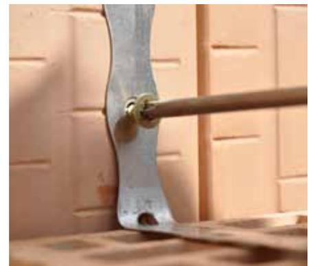
② Bohren des Loches ohne Schlagfunktion mit einem Durchmesser von 8 mm und einer Mindestdiefe von 60 mm.
