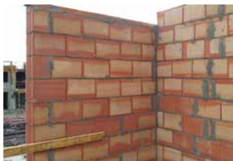
Der min. Ziegelverbund beträgt 95 mm. Die Stellen der Zuschnitte der Ziegel werden vermörtelt.
