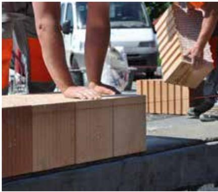
**1a** Das Anlegen der ersten Reihe geschliffener Ziegel in frisches ausgeglichenes Mörtelbett (der Mörtel wird im ausreichend feuchten Zustand gehalten), Ziegel sind vom Staub und anderen Verunreinigungen befreit, am ersten Tag max. 3 Reihen.
