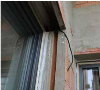
⑫ Verwendet man Rollladenstürze, so kann man in den Ergänzungsziegeln eine Nut für die Führungsschienen der Beschattungstechnik ausschneiden.
