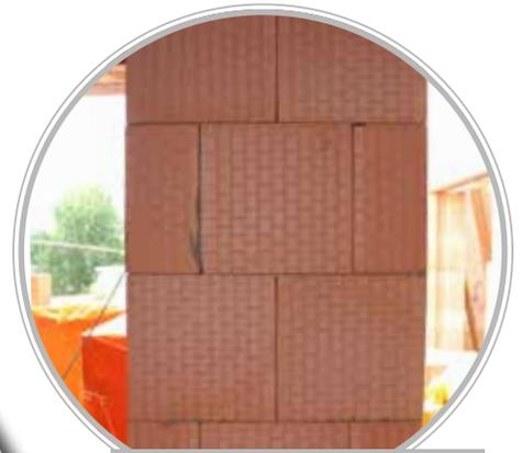
Tragpfeiler werden im Längenmodul 250 mm gefertigt
