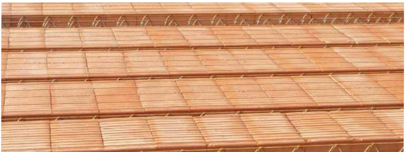
Ansicht auf die verlegten Träger und Einlagesteine (vor der Verlegung der Bewehrungsnetze)
