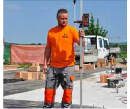
③ Mit Hilfe eines Nivelliergerätes und einer Latte vermessen wir höhenmäßig die Fundamentplatte an der Stelle zukünftiger Wände gemäß der Projektdokumentation. Wir bestimmen somit den höchsten Punkt der Fundamentplatte.
