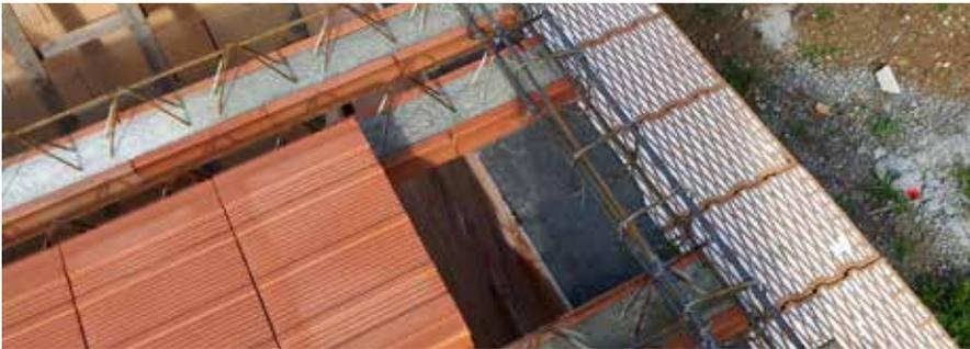
Deckenaufleger auf der Mauerkrone auf Bitumenband.
