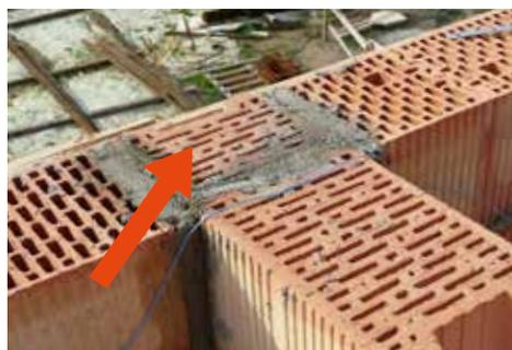
Wir empfehlen, dass das Mauerwerk aus akustischen Ziegeln bis zur äußeren Vorderseite des Außenmauerwerks durchgeführt wird.
