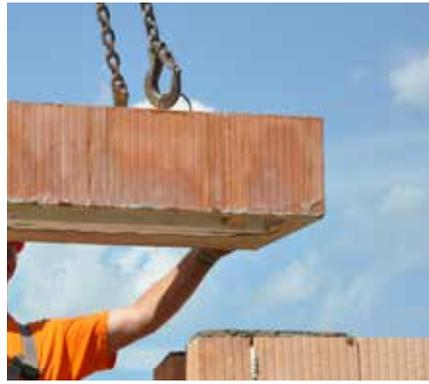
② Zur Manipulation mittels eines Krans werden Hängehaken benutzt. Nach Platzierung des Sturzes sind die Haken zu entfernen (abzuschneiden).
