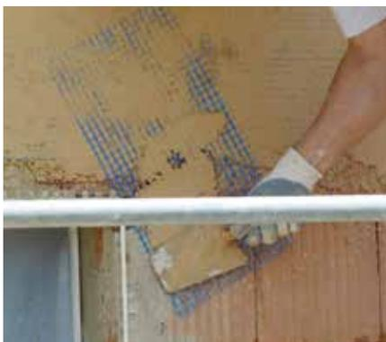
⑦ An den Ecken von Bauöffnungen wird der Putz mit Glastextilgitter armiert (mind. 8x8mm), damit man eine mögliche Entstehung von Rissen im Putz in der Ecke vermeidet.
