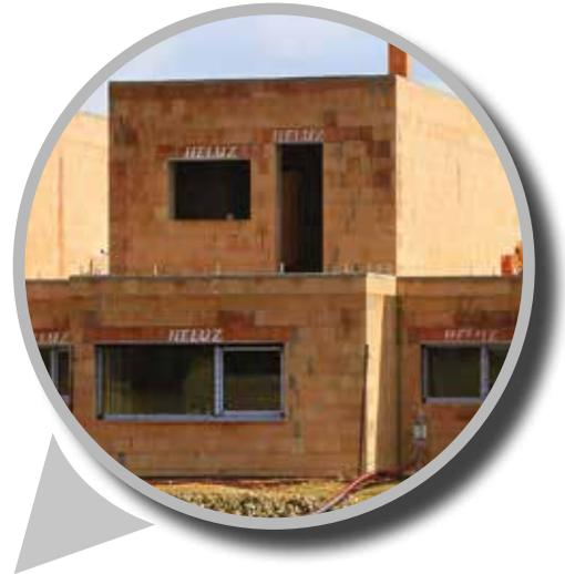
Der Sturz verfügt über einen Raum für die Beschattungstechnik und ist **völlig statisch tragend**. Wir empfehlen einen Sturz mit größerer Länge ( $\geq 2,5$  m) in der Mitte zu unterstützen.
