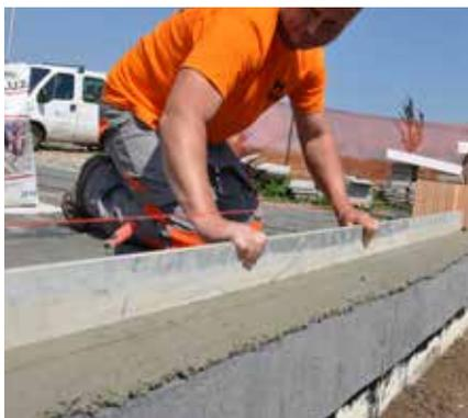
⑤ Wir tragen den Mörtel zwischen die Führungsschienen der Vorrichtungen des Ausgleichssatzes auf und ziehen ihn mit Hilfe einer Aluminiumlatte eben ab. Den überschüssigen Mörtel auf den Seiten schneiden wir, der Alulatte entlang, mit der Mauerkelle ab. Dann wird die Vorrichtung, in Richtung des Mörtelauftrages, versetzt und der Vorgang wiederholt.
