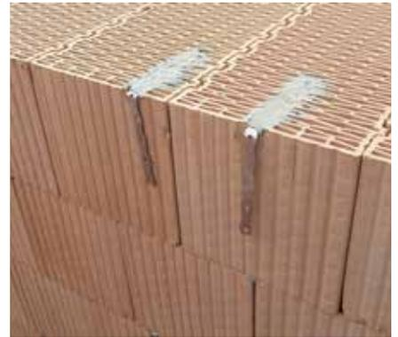
10 Im Laufe der Mauerung ist es empfehlenswert, die Systemanker zum Verbinden der Innenwände und der Trennwände einzubauen. Die Ziegel werden an der Stelle der Befestigung der Anker leicht geschliffen, z. B. mit einer Raspel.
