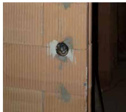
Für Kabelleitungen z.B. in Trennwänden ist es vorteilhaft, die Hohlkammern der Ziegel zu verwenden. Dadurch wird die Menge der Schlitzze reduziert.
