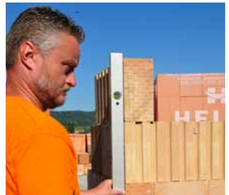
⑤ Während der Ausmauerung werden ständig die richtige Position und die Spannung der Maurerschnur kontrolliert.
