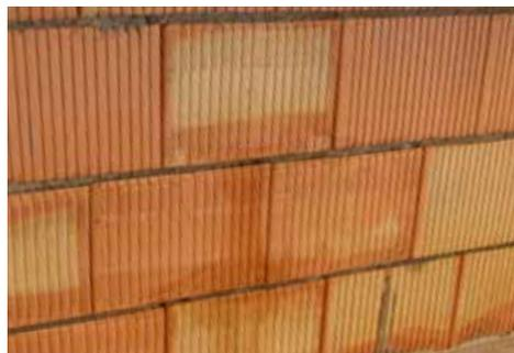
Es ist erforderlich, Lagerfugen bis zur Vorderseite des Mauerwerks zu vermörteln.
