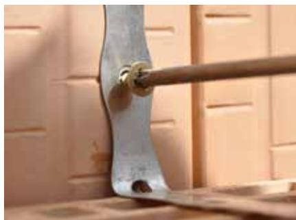
Einlegen der Anker zur Verbindung der Innenwände (auch nachträgliche Montage möglich).
