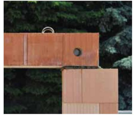
③ Die tragenden Rollladen- und Jalousienstürze HELUZ werden in ein Mörtelbett aus wärmedämmendem Mörtel HELUZ TREND mit einer Mindeststärke von 6 mm gelegt. Das Auflager dieser Stürze beträgt mindestens 200 mm. Für die manuelle Bedienung beträgt das empfohlene Auflager 220 mm auf der Seite der Bedienung.
