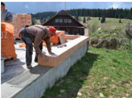
Ausgleichen des Anlegemörtels beim Mauerwerk aus geschliffenen Ziegeln.
