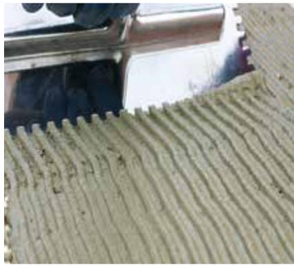
**1b** Das Anlegen der ersten Reihe geschliffener Ziegel in einen Tag ausgehärteten Mörtel, auf den der Dünnbettmörtel vor der Verlegung der Ziegel mittels des Zahnglätters (Zahnung 6 mm) aufgetragen wird.
