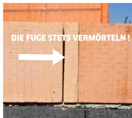
**4** Falls man die erste Reihe des Mauerwerks nicht aus ganzen Ziegeln ausmauern kann, muss man die Ziegelblöcke schneiden. Eine Spalte mit der Breite von 5-15 mm zwischen dem Zuschnitt und dem Ziegel füllen wir vorzugsweise mit Hilfe eines wärmedämmenden Mörtels aus.
