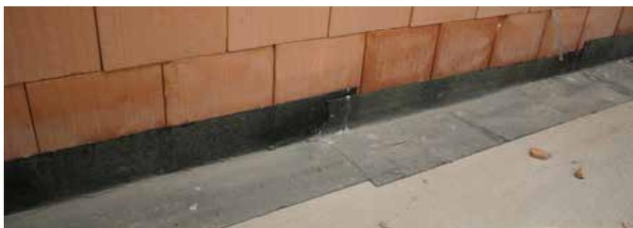
Schutz des Mauerwerksockels gegen Wasser und Sicherstellung der Luftdichtheit des Details mit Hilfe einer Rückverbindung mit der Feuchtigkeitisolierung.
