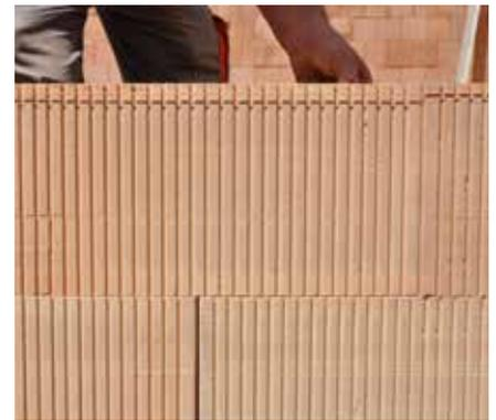
③ Trennwände aus geschliffenen Ziegeln werden auf Dünnbettmörtel, in den die Ziegel eingetaucht werden gemauert. Die Laibungen der Bauöffnungen werden, stets mit Nuten bzw. mit Federn der Ziegel, nicht mit geschnittenen Ziegelseiten, abgeschlossen.
