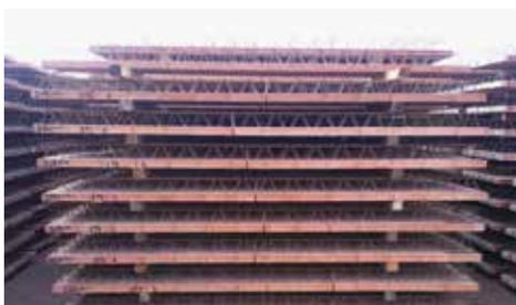
Stürze und Deckenträger werden auf Stapellatten so gelagert dass eine übermäßige Durchbiegung (Deformation) auf Grund ihres Eigengewichtes verhindert wird. Diese Stapellatten werden in den jeweiligen Lagen genau übereinander platziert.
