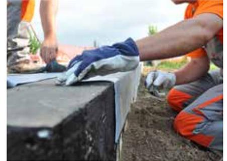
① Die Fundamentplatte muss eben (max. Höhendifferenz 20 mm) und frei von eventuellen Unebenheiten sein. Auch die in der Fundamentplatte liegenden Leitungen sollten bereits ausgeführt sein.
