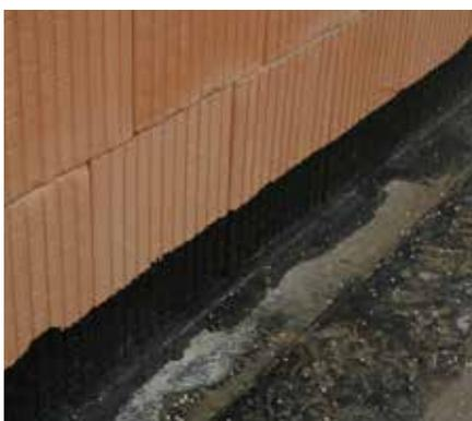
**5** Wir empfehlen auch die Verbindung des Mauerwerkes an die Bodenplatte an der Innenseite gegen Feuchtigkeit, ca. 10cm hoch, zu isolieren. Z.B. mit bituminösen Anstrichen, PVC Folien oder durch Fertigstellung einer Rückverbindung mit der Mauersperrbahn. Wasserpfützen werden von der Fundamentplatte mit Hilfe eines Besens ausgekehrt.
