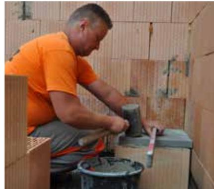
① Das Kaminsystem HELUZ wird auf einer Feuchtigkeitsisolierung errichtet, auf der zwei in ein Mörtelbett versetzte Ziegelformsteine (H20) gebettet werden. Diese kann man auf beliebige Größe anpassen. Auf diese Formsteine tragen wir Mörtel (HLM) auf und setzen die Betonfundamentplatte (HPD) zumindest auf das Niveau des fertigen Bodens. Wir richten die Platte mittels Gummihammer und Wasserwaage aus. Die Platte muss unbedingt waagrecht ausgerichtet sein.
