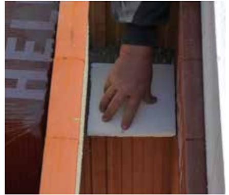
④ Zwischen den Stürzen wird eine Unterlage aus wärmedämmender Isolierung mit gleicher Höhe wie das Mörtelbett eingelegt. Das Mörtelbett kann auch aus dem Mörtel HELUZ TREND in der gesamten Breite des Mauerwerks durchgeführt werden.
