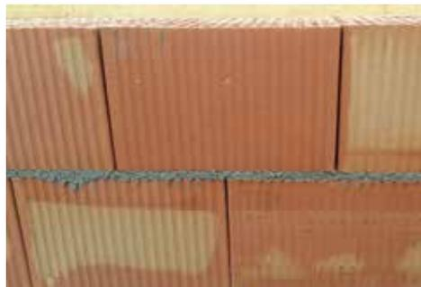
Der Mörtel wird in der Stärke von 12 mm (6-15 mm) bis zur Vorderseite des Mauerwerks aufgetragen.
