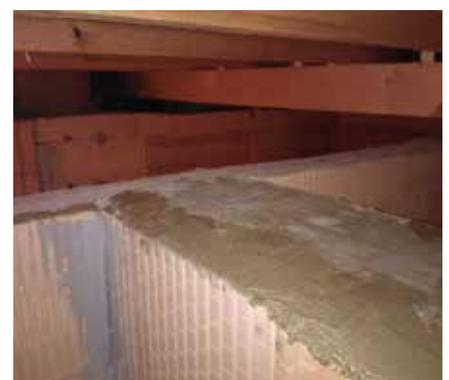
⑤ Zur Fertigstellung der Laibungsstürze von Bauöffnungen werden in Trennwänden flache Stürze mit gleicher Breite wie das Mauerwerk verwendet. Die Mindestlänge der Auflager bei flachen Stürzen beträgt 125 mm. Die Stoßfuge zwischen der Trennwand und dem tragenden Mauerwerk wird komplett vermörtelt.
