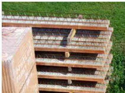
Das gelieferte Material wird kontrolliert - Typ, Länge und Anzahl der Deckenträger, Einlagesteine.
