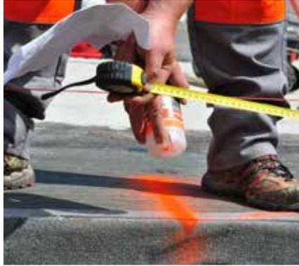
② Vor dem Auftragen des Mörtels markieren wir sämtliche Bauöffnungen (z. B. Türen).
