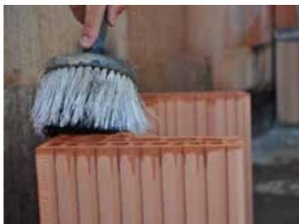
Die Verbindungs- und auch Auflageflächen der Ziegelkaminformsteine müssen vor dem Auftragen des Mörtels von Verunreinigungen befreit und mit Wasser befeuchtet werden.
