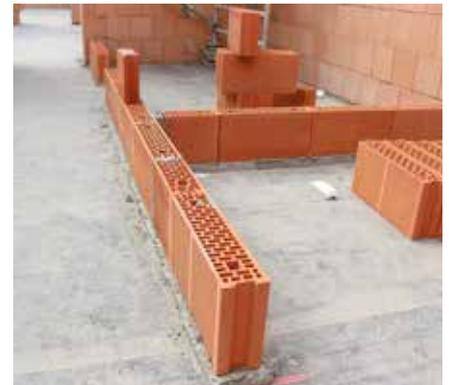
④ Während der Mauerung wird die minimale Überlappung eingehalten. In Eck- und Anschlußbereichen von Wänden werden Ziegel im Verbund gemauert. Stoßfugen, die keine Nut-Feder-Verbindung besitzen, werden vermörtelt. Spalten mit einer Breite von 5-15 mm zwischen dem Zugschnitt und dem Ziegel oder in Fugen, wo es keine Nut-Feder-Verbindung gibt, füllt man vorzugsweise mit Hilfe eines Mauermörtels aus. Breitere Fugen werden stets mit wärmedämmendem Mörtel und einem Ziegelzuschnitt ausgefüllt.
