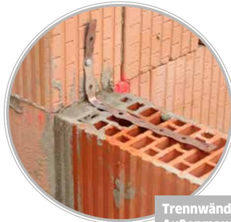
Trennwände werden an die Außenmauern mit Hilfe der System-Edelstahllanker verankert
