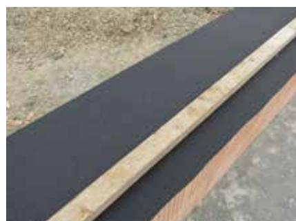
Im Bau befindliche Wände sind im Falle eines zu erwarteten Regens mit einer Überzugisolierung zu schützen - sowohl die Krone, als auch die Fensterbänke.
