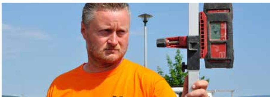
Höhenvermessung des Untergrunds an der Stelle zukünftiger Wände und Bestimmung des höchsten Punktes, aus dem sich die Höhe des Mörtelbetts ergeben wird. Stärke mind. 10 mm und max. 40 mm.
