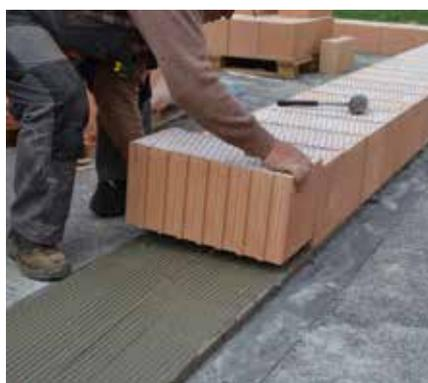
**3** Wir verbinden die Ziegelblöcke an Enden der Wand an der äußeren Seite des Mauerwerks mit einer Mauerschnur. Wir verlegen die Ziegel entlang der gespannten Schnur ins Mörtelbett von oben mit dem Einsetzen der Feder in die Nuten. Die Position der Ziegelblöcke richten wir mit einem Gummihammer anhand einer Wasserwaage aus.
