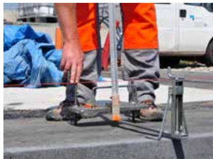
Einer der wichtigsten Punkte für das Mauern mit geschliffenen Ziegeln ist das Ausgleichen der ersten Ziegelreihe im Sockel der Wand mit sog. Anlegemörtel. Es wird ein Ausgleichssatz und ein Nivelliergerät mit guter Genauigkeit verwendet (professionelle Produktreihe).
