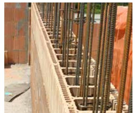
Das Vergiessen der Hohlräume wird mit Mörtel oder Beton max. nach 1,0 m durchgeführt (4 Ziegelreihen).
