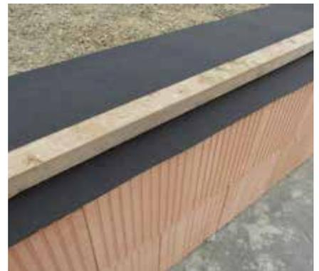
11 Falls die Höhe des zukünftigen Mauerwerks nicht im Höhenmodul 250 mm liegt, kann man ergänzende niedrige Ziegel verwenden oder die Ziegel auf die gewünschte Höhe zuschneiden. Das Schneiden kann man auf Tischkreissägen oder mit manuellen elektrischen Sägen durchführen.
