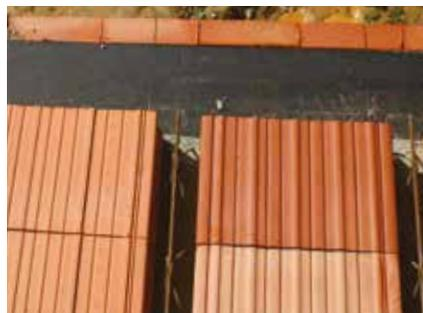
Ein Bitumenband mit der Stärke 3,5 mm wird nur an der Stelle der Deckenaufleger und des künftigen Stahlbeton-Mauerankers verlegt!
