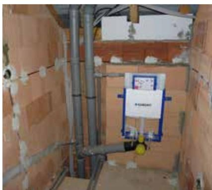
Es wird empfohlen keine Wasser- und Abwasserleitungen ins Mauerwerk einzubauen. An der Stelle der Steigleitungen, sollte das Mauerwerk vor der Installation technischer Leitungen verputzt werden.
