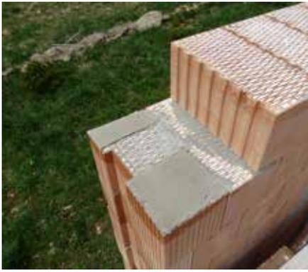
① Vor dem Einsetzen der Stürze im Außenmauerwerk wird ein Mörtelbett aus wärmedämmenden Mörtel HELUZ TREND vorbereitet (man kann ihn unter der eingelegten Wärmedämmung zwischen den Stürzen auslassen).
