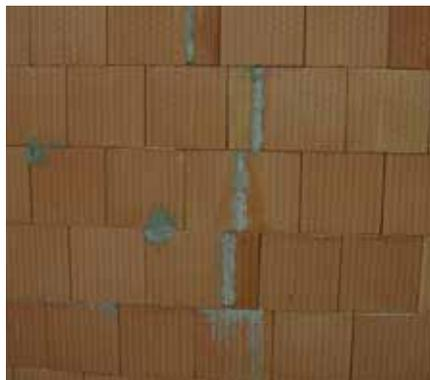
Im Bereich von Ziegelzuschnitten müssen die Fugen vollständig mit Mörtel ausgefüllt werden.
