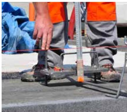
④ Der höchste Punkt der Fundamentplatte wird uns als ein Ausgangspunkt dienen, aus dem die Höhe des Anlegemörtels abgeleitet wird. Diese Höhe muss um 10 mm größer sein als die Höhe des höchsten Punktes. Auf diese Höhe stellen wir dann die Führungsschienen der Vorrichtungen des Ausgleichssatzes ein. Die Stärke des Ausgleichsmörtelbetts aus dem Anlegemörtel muss dann > 10 mm sein. Falls die Stärke größer als 40 mm ist, muss man den Höhenausgleich in zwei Arbeitsschritten durchführen.
