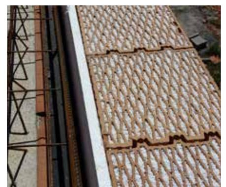
① Am Umfang der Deckenkonstruktion werden von der äußeren Seite Ringankersteine verlegt. In der horizontalen Richtung werden sie stoßdicht, auf Feder und Nut verlegt.
