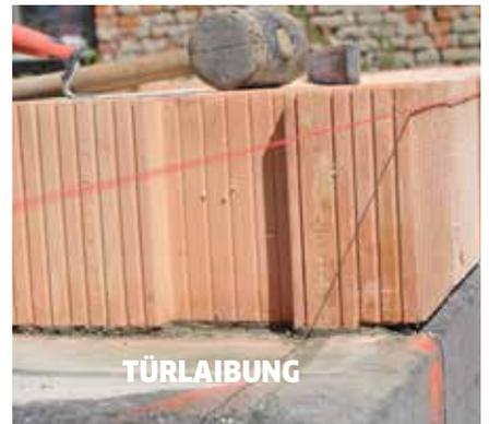
③ Bei Temperaturen über 10°C werden die Ziegel vor Auftragen des Mörtels mit Wasser befeuchtet.
