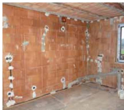
Ansicht auf eingebaute Elektroninstallationsdosen und verlegte Kabel. Schlitzze für Wasser- und Abwasserleitungen müssen möglichst klein sein.
