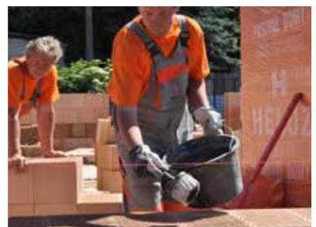
② Für die Vorbereitung des Mörtels brauchen wir einen sauberen Eimer, in den wir die Wassermenge gemäß der Anleitung auf dem Mörtelsack einfüllen. Während ständigen Mischens geben wir die trockene Mörtelmischung zu. Langsam mit einem elektrischen Rührwerk mit ausreichender Leistung rühren (wir empfehlen ein professionelles Rührwerk zu verwenden), bis der Mörtel eine zähflüssige Konsistenz hat.
