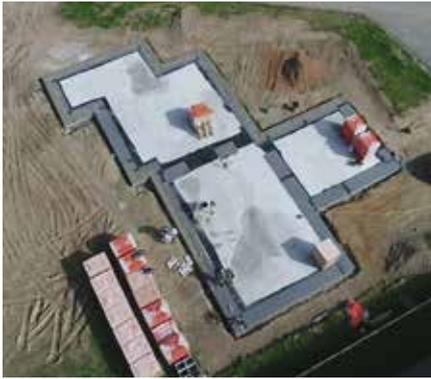
① Ansicht auf die Fundamentplatte, auf die der Anlegemörtel aufgetragen wird. Die Anordnung der Paletten darf weder die Vermessung der Fundamentplatte noch folgende Arbeiten behindern.
