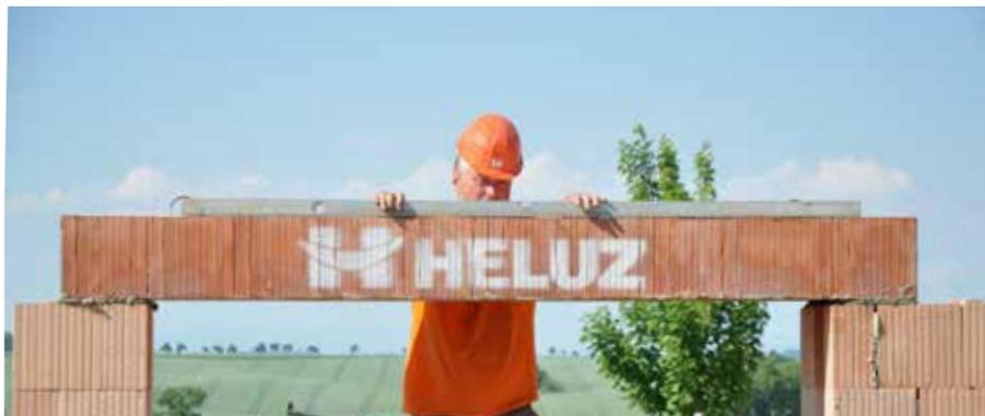
④ Besondere Bedeutung hat die perfekte Ebenheit des Einsetzens des Sturzes. Diese stellt die problemlose Montage der Jalousien und Rollladen sicher.
