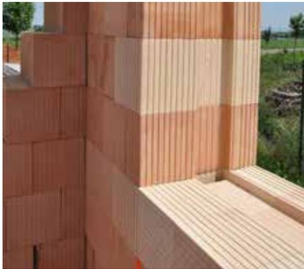
9 Bei Tür- und Fensterlaibung werden Ergänzungsziegel verwendet, um den gegenseitigen Ziegelverbund sicherzustellen. Desweiteren helfen sie die Verankerung von Tür- und Fensterrahmen sowie die Führungsschienen der Beschattungstechnik zu befestigen und Wärmebrücken nach Einsetzen des wärmedämmenden Materials in Ziegeltaschen zu reduzieren.
