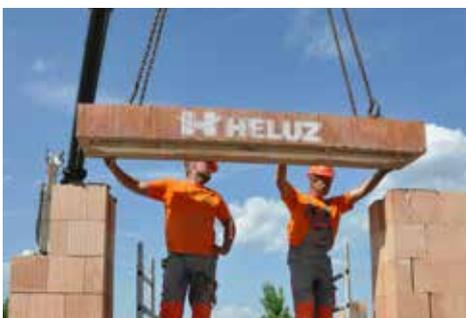
Die Manipulation mit Rollladenstürzen wird mit Hilfe von Hubeinrichtungen (am häufigsten Kräne, eventuell Lastkraftwagen mit hydraulischem Arm) und Aufhängehaken durchgeführt.
