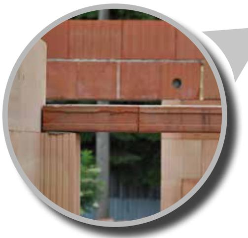
Flache Stürze sind selbst nicht ausreichend tragend. Vor der Übermauerung muss man den flachen Sturz eben unterstützen, dabei darf der Abstand zwischen den Stützen nicht größer als 1,0 m sein, siehe **Abb. Montageunterstützung bei flachen Stürzen**. Entfernung der Stütze ungefähr 2 Wochen nach dem Aushärten des Mörtels
