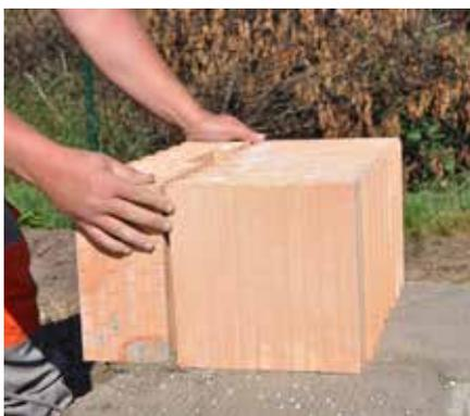
**2** Wir beginnen die Mauerung der Wand mit dem Anlegen der Ecke. Die Regeln für den Aufbau der Ecken, für die benötigte Mauerstärke, sind einzuhalten. Nähere Details über den Aufbau der Ecke Seite 41.
