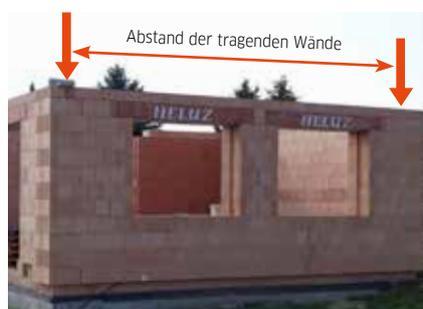
Vor der eigentlichen Montage empfehlen wir DEN LICHTEN ABSTAND DER TRAGENDEN WÄNDE ZU ÜBERPRÜFEN (der Unterzüge) - Toleranz max. + 20 mm.
