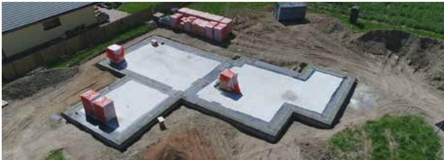
③ Fertiggestellte Fundamentplatte mit aufgeflämmt Bitumenbändern unter dem zukünftigen tragenden Mauerwerk.
