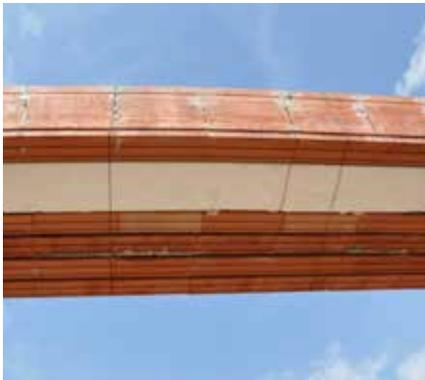
⑥ Den Komplex der Stürze sichern wir durch Zusammenziehen mit einem Binddraht an mindestens zwei Stellen - ungefähr 30 cm von der Laibung der Bauöffnung.
