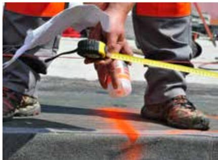
Vermessung der Fundamentplatte bzw. Kellerdecke und das Anlegen der Wände und Öffnungen.
