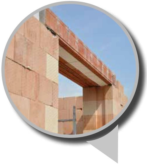
Der Sturz ist **völlig statisch tragend** - nach dem Einsetzen in den Mörtel kann man den Sturz direkt ohne Unterstellung schon im Montagezustand belasten.
